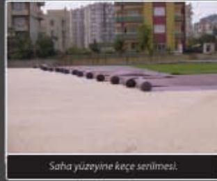
Saha yüzeyine sentetik çim serilmesi
