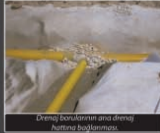
Drenaj Kanallarına jeotekstik bohçalama yapılması ve drenaj borularının döşenmesi
